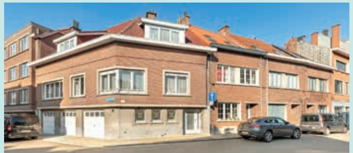
Te renoveren hoekwoning Nieuw Kwartier
